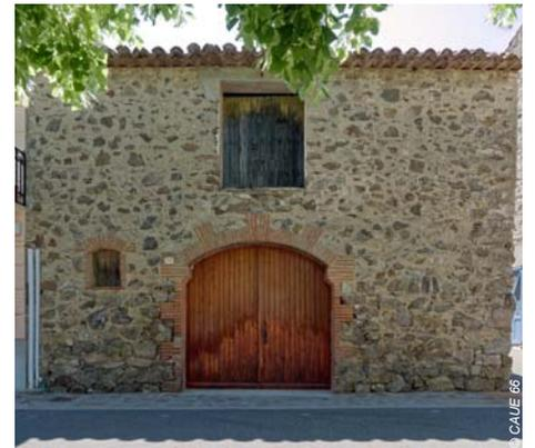
Ces bâtiments comportent des ouvertures adaptées à leur usage (agricole ou artisanal). Ce sont donc des maçonneries rustiques où les *moellons*\* restent plus ou moins apparents pour des raisons économiques.
