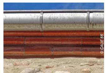
La génoise, en plus de sa qualité architecturale, offre une utilité technique très importante. Ce débord évite les ruissellements d'eau pluviale qui dégradent rapidement les façades et favorisent l'insalubrité des locaux. Il protège également la toiture des oiseaux et des rongeurs.
