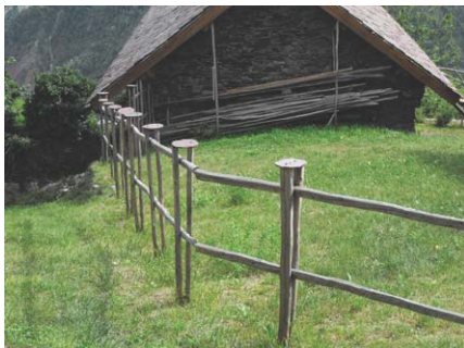
Modèle 1 : 2 lisses bois local, protection des poteaux verticaux
