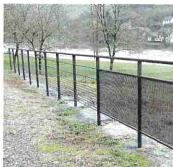
Modèles de garde-corps en acier thermolaqué et/ou câbles tendus en inox
