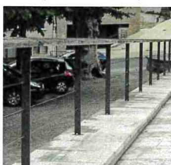
Modèles de garde-corps en acier thermolaqué et/ou câbles tendus en inox
