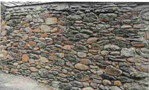
Muret en pierre maçonnée (schiste et galets) à réaliser
