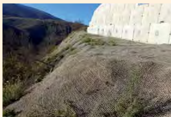
Chantier sur la RN116 - © PNRPC
