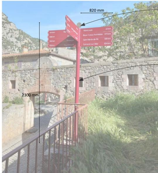
Mât aluminium thermolaqué RAL 8012, Diamètre 90 mm, avec bouchon et indication fixe des directions NSEO, en lettres découpées alu laquées
