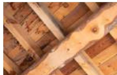
Moulin à foulon, Ayguatèbia : poutres en pin à crochets
